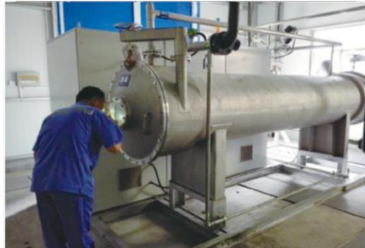
**分析：**经检查发现，该套臭氧系统在前期的检修后，维修人员对发生室内放电单元进行电气连接时工作疏忽，将一放电单元电气连接体没紧固，当臭氧发生器在半负荷低电压工作时，电气系统的放电单元无异常现象，当臭氧发生器在满负荷高电压工作时，施加到放电单元体上的电压高达7000伏以上，通过放电单元体的电流加大，这时就在松动的连接体间隙产生电弧。
